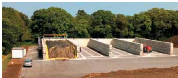
Na volné ploše s roštovým provětráváním
